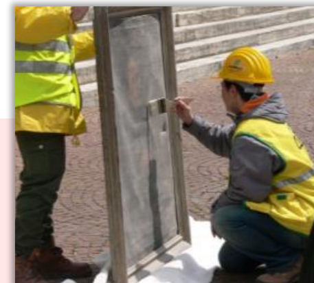
Messa in sicurezza - Opere di preconsolidamento
